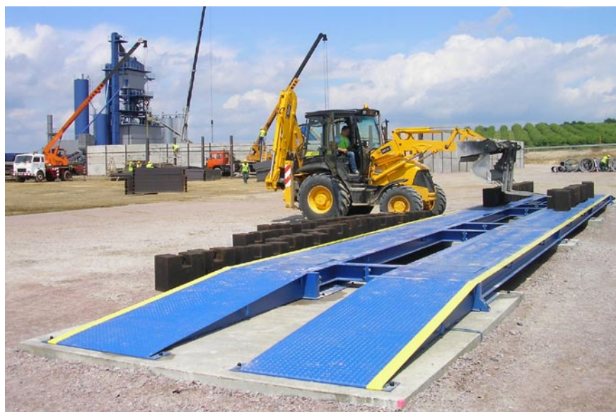
Waga Mars-STP – jedna z 4 szt. wykorzystywanych przez firmę Skanska przy budowie autostrady A1
