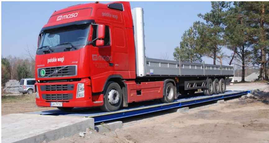
Waga najazdowa Mars-STZ instalowana jest na żelbetowym fundamencie
